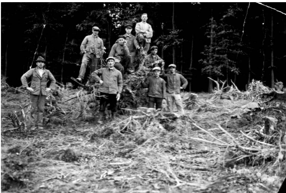
Rodungsarbeiten in der „Kuhlheed“ (Anfang der 1930er Jahre)
